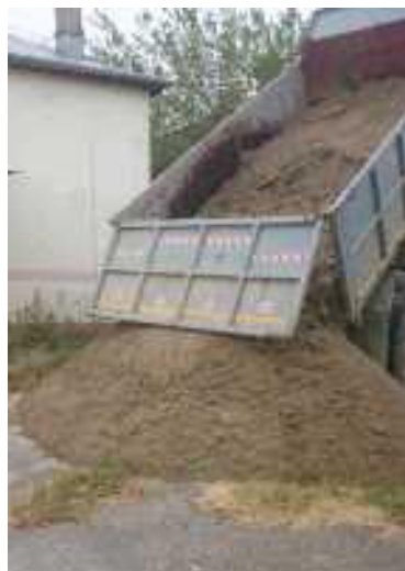
Lastbilen håller på att lasta av sanden på platsen där sandplanen kommer förläggas på skolgården.
